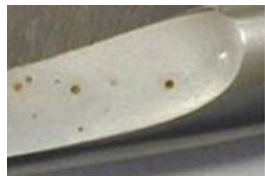
Corrosão por picadas
